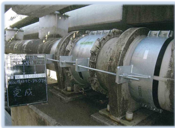
水管橋簡易耐震補強工事
