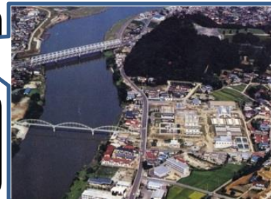
渡利浄水場全景
