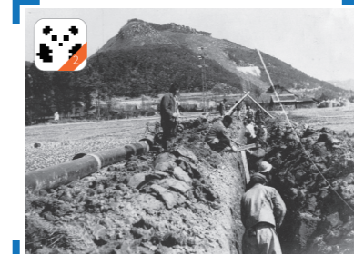
▲信夫山周辺配管工事(第3次拡張事業)
