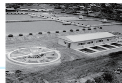
▲渡利浄水場急速ろ過池増設(第4次拡張事業)
