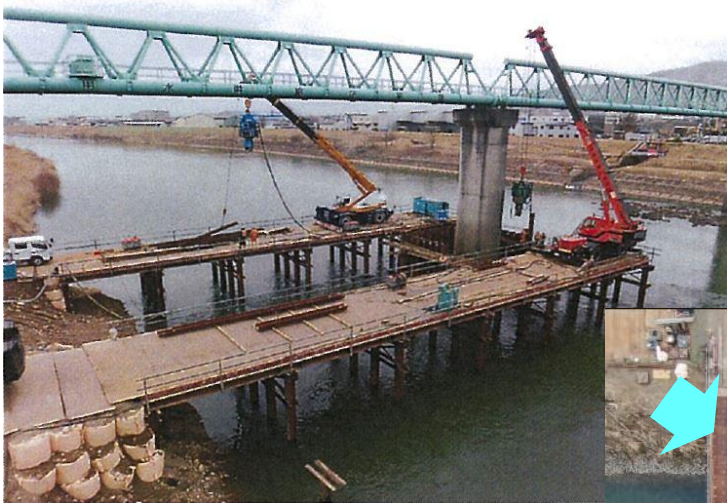
STEP1(仮設ヤード)
