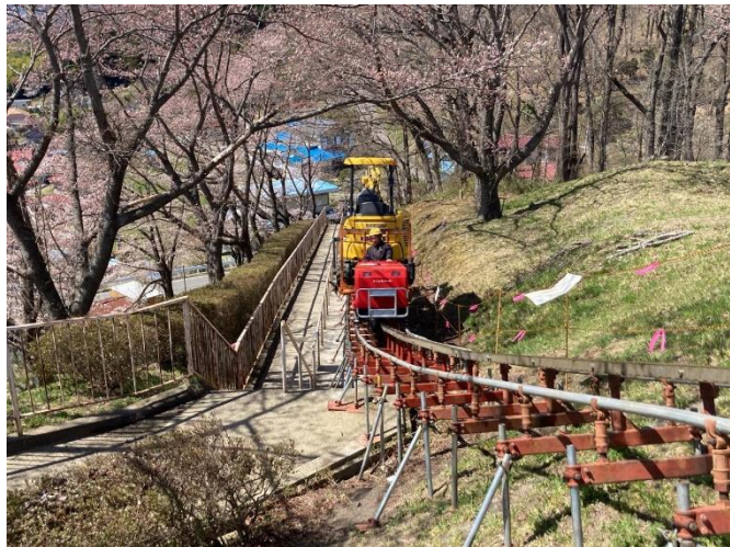
モノレール運搬 (重機・資材運搬)
