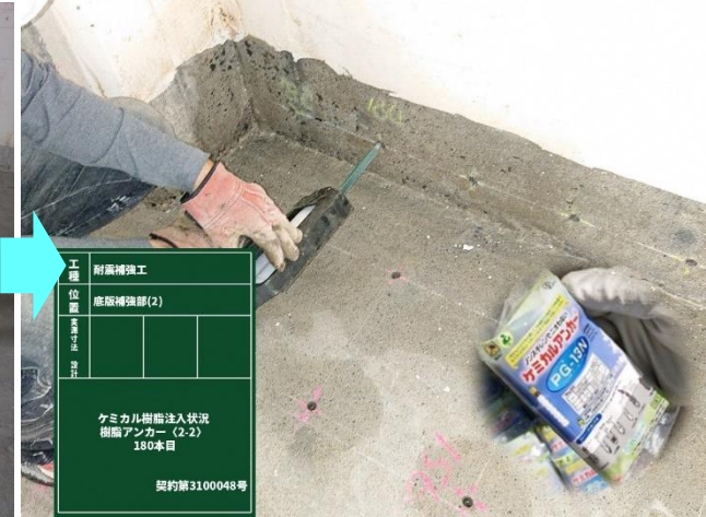
ケミカルアンカー打設作業(完)
