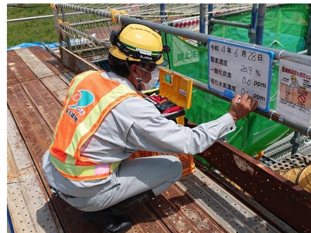
酸素濃度計測 (安全対策)
