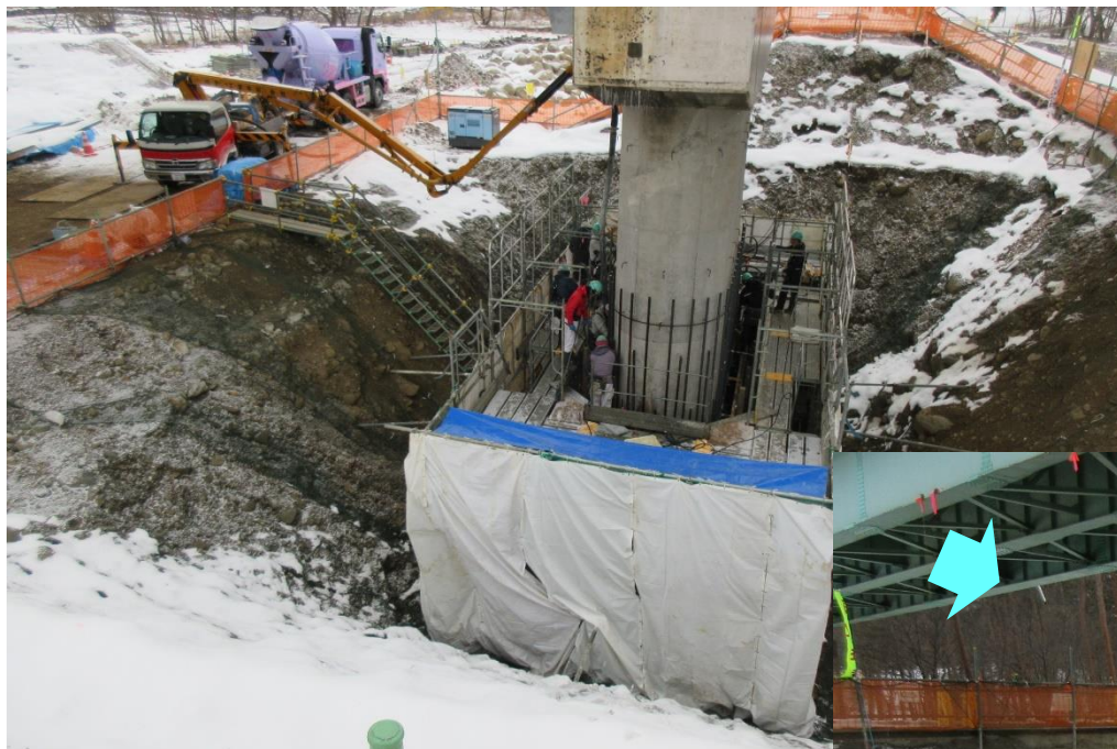
STEP8(コンクリート打設)
