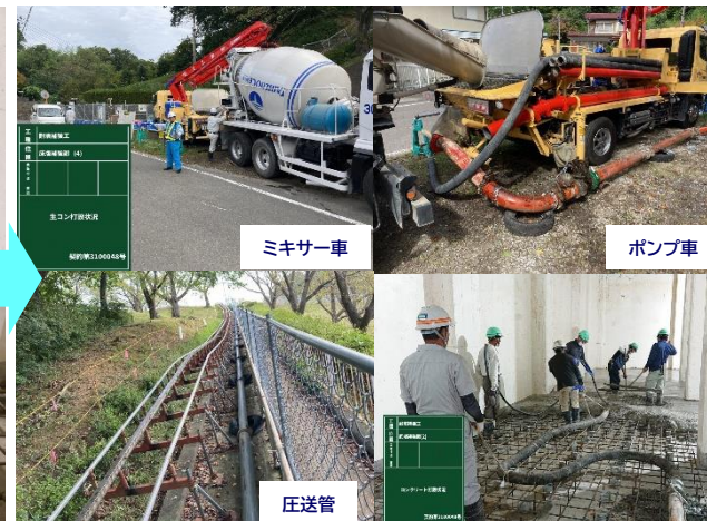
コンクリート打設作業 (完)
