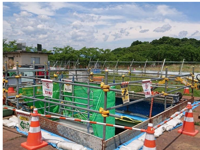
配水池開口部 (資材搬入口)
