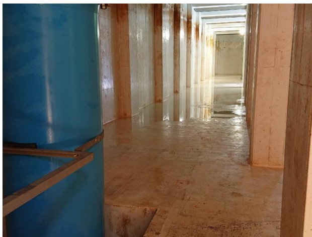
配水池内部 (底版補強)
