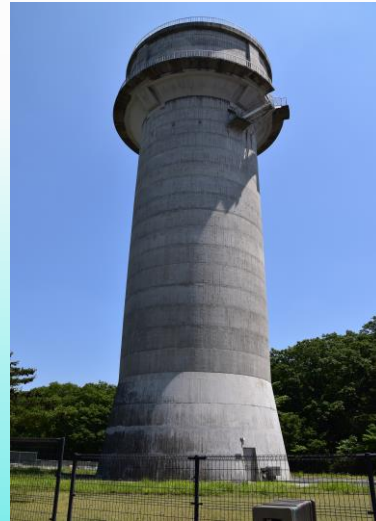
蓬萊高架水槽
