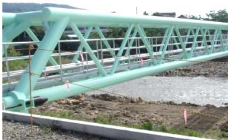
摺上川水管橋架替工事
