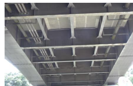
飯坂大橋添架管塗装替修繕工事
