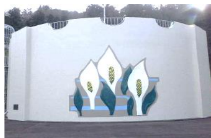
金剛山配水池防水塗装替修繕工事
