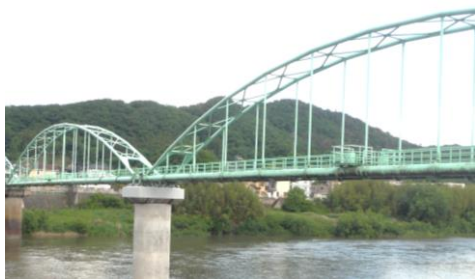
阿武隈川水管橋耐震補強工事
