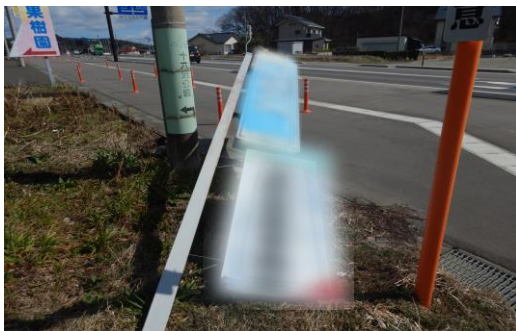
(例①) 転倒した屋外広告物
