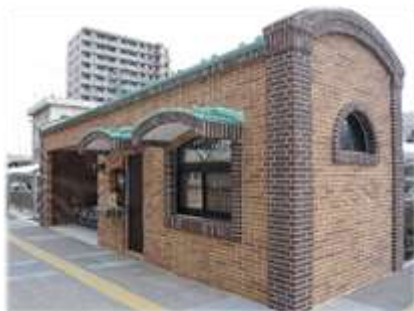
駅西口自転車管理棟
