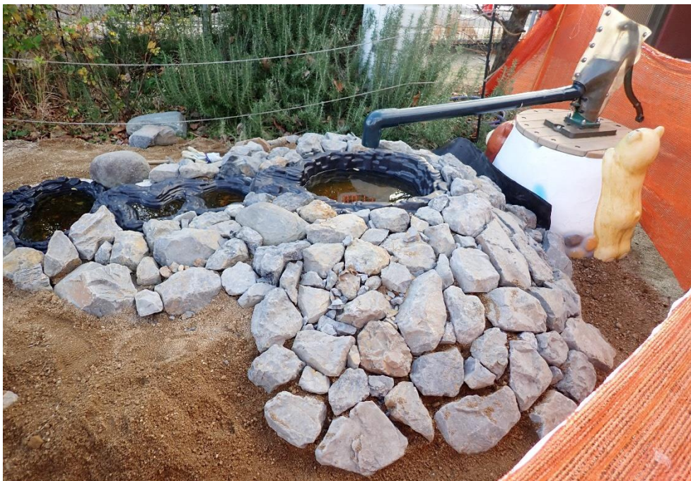
<水路・ビオトープ工事中>
