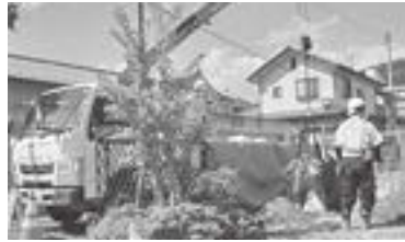
住宅除染や道路除染などを進め、仮置場の準備が整った地区では、宅地内に保管している除去土壌の搬出を実施しました
