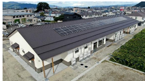
清水支所新庁舎
