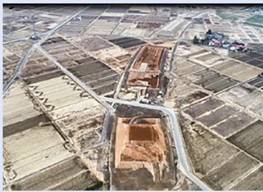
向田地区道路改良工事(平成31年2月) 資料提供:国土交通省東北地方整備局福島河川国道事務所
