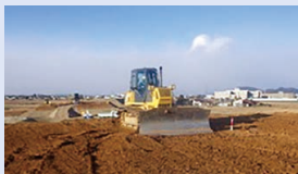
盛土施工状況(平成31年2月)
