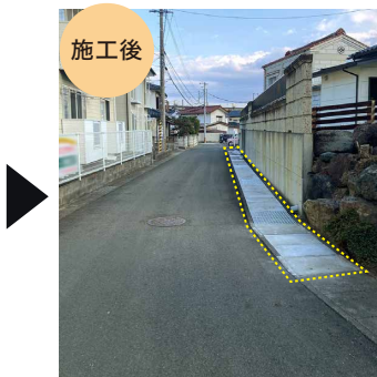
道路側溝修繕工事 (吉井田地区)
