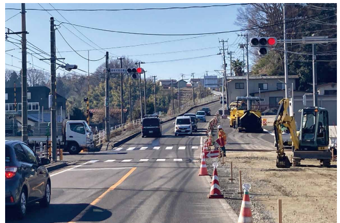
■車線の拡幅工事が進む様子(令和5年2月撮影)
