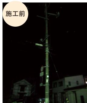
街路灯設置工事 (中央東地区)
