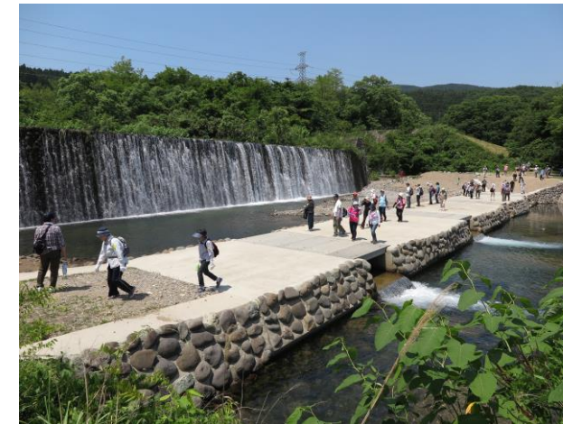
地蔵原堰堤(登録有形文化財)を歩く あらかわふるさとの川ウォーキング大会
