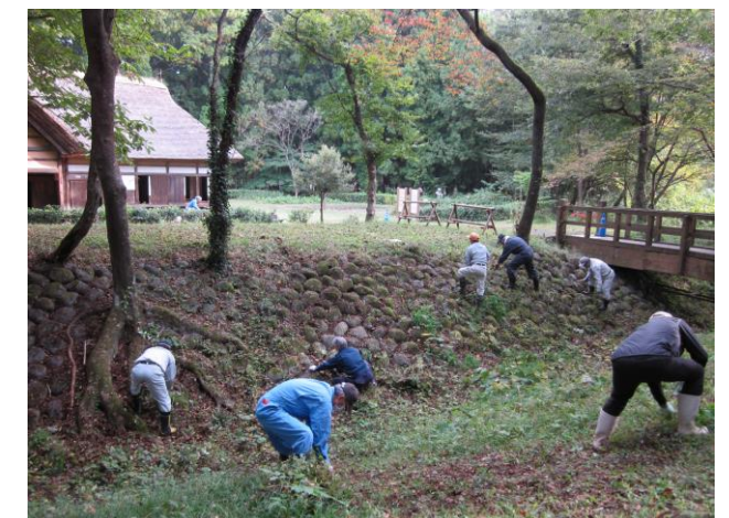
民家園内の霞堤の除草作業
