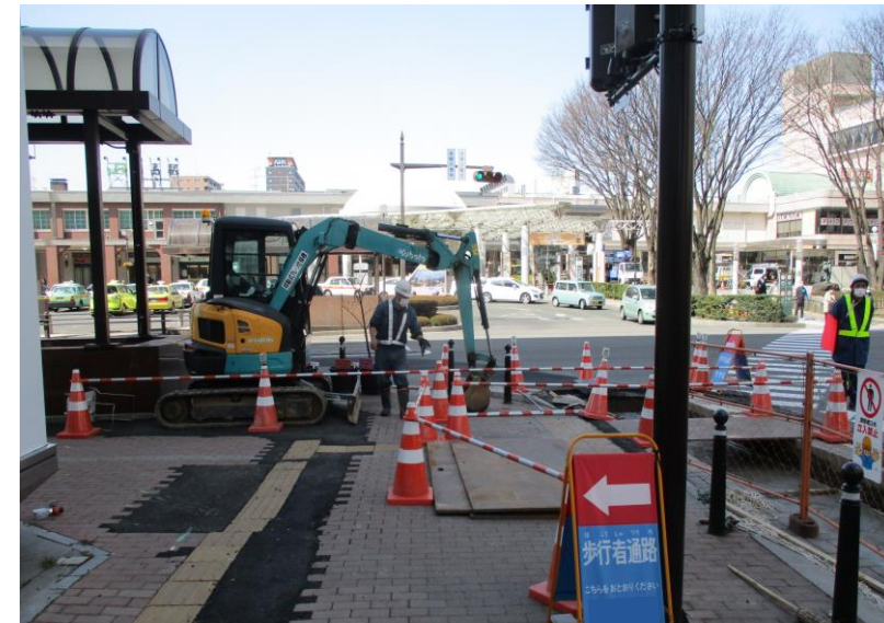
【現況】インフラ移転工事
