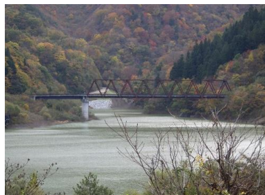
③中津川橋 (穴平・滑沢線)
