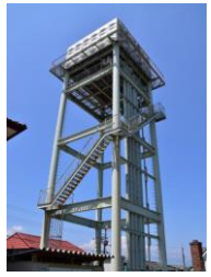
桜台高架水槽
