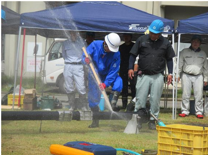
① 応急復旧訓練の様子 漏水修繕訓練
