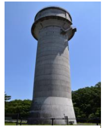
蓬萊高架水槽
