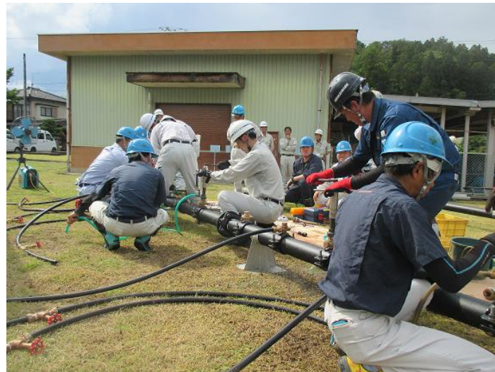
① 応急復旧訓練の様子 分岐施工訓練
