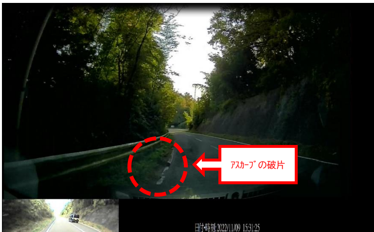
▲事故発生時におけるドライブレコーダーの記録映像
