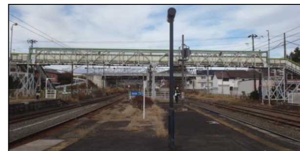
①松川跨線人道橋
