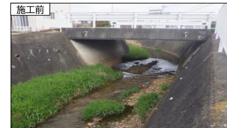
河川土砂浚渫 実施状況 馬川
