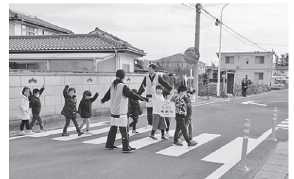
区画線とポール設置をした交差点
