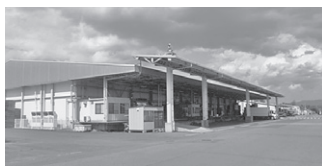
卸売市場内の冷蔵庫棟
