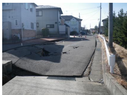
道路陥没による管渠被災[黒岩字弥生地内]
