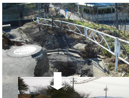
道路陥没による管渠被災[黒岩字弥生地内]
