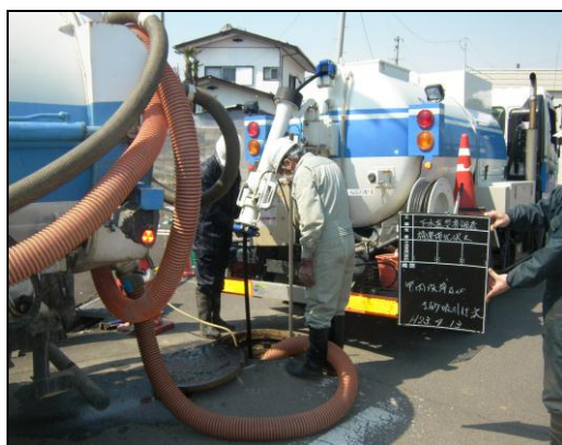
バキューム車及び強力吸引車により滞水を除去
