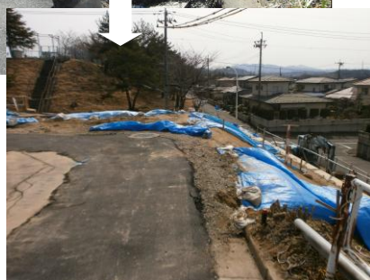
道路法面崩落による管渠被災並びに復旧状況[蓬萊町五丁目地内]
