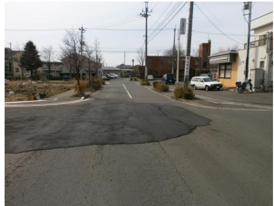
応急復旧の様子
