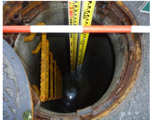
路面は正常のようだが、マンホール内は滞水している。[鎌田字一本松地内]
