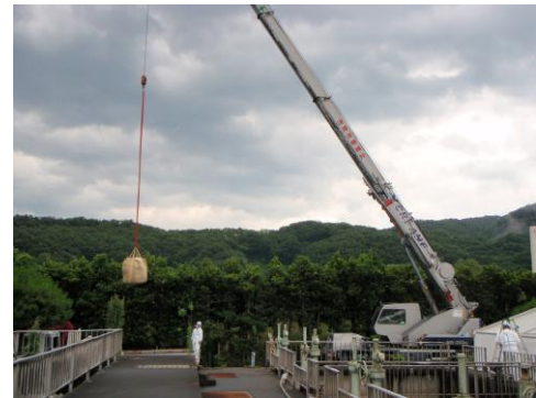
反応槽(遊休)への移設状況
