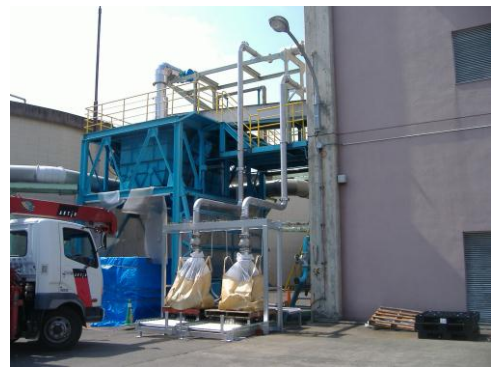
脱水汚泥を大型土のう袋に詰めている
