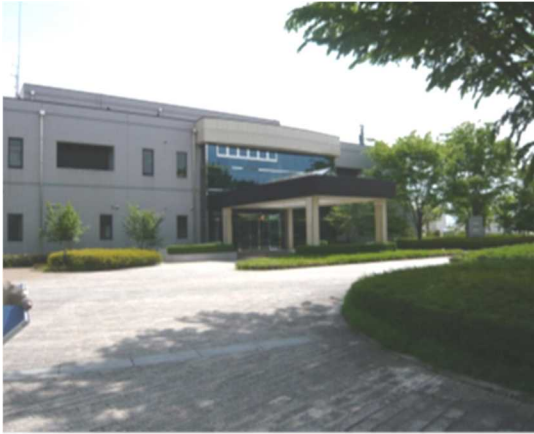
県北浄化センター（県施設）
