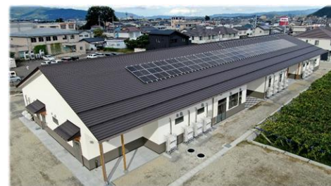
ニアリーZEBの新清水支所
