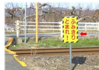
第4種踏切安全対策
