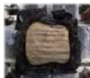
燃焼後の太い柱
