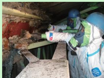
吹付け石綿の除去作業の様子
