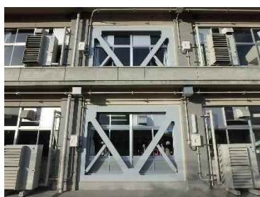
耐震補強 事例
