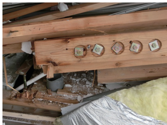
写真7 写真6の建物の写真筋かい端部、柱脚接合部
