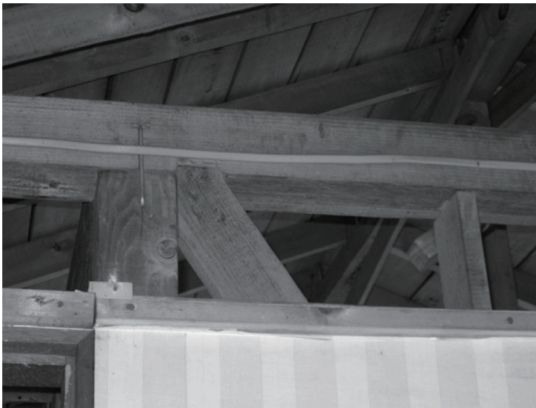
写真Ⅱ.2.2.3 柱頭接合部の例 (金物が使われていない例)
