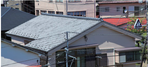
健全な瓦屋根
