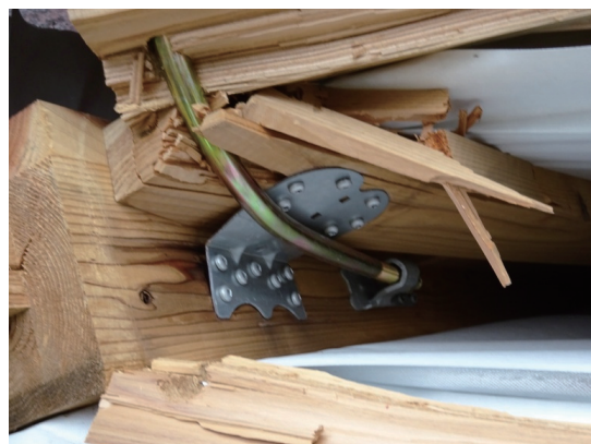
写真5 写真4の建物の写真筋かい端部、柱脚接合部
