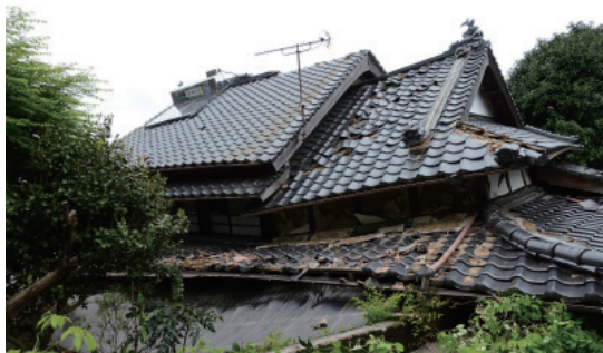
写真8 倒壊した木造住宅
