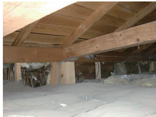
写真Ⅱ.2.2.2 柱頭接合部の例 (金物が使われていない例)
