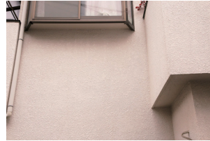
健全な外壁（ひび割れ等がない）
