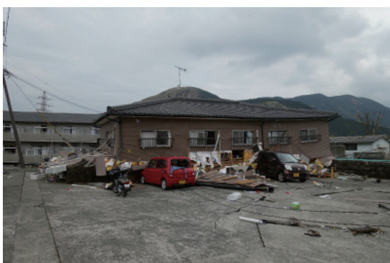
写真 14 倒壊した木造アパート
