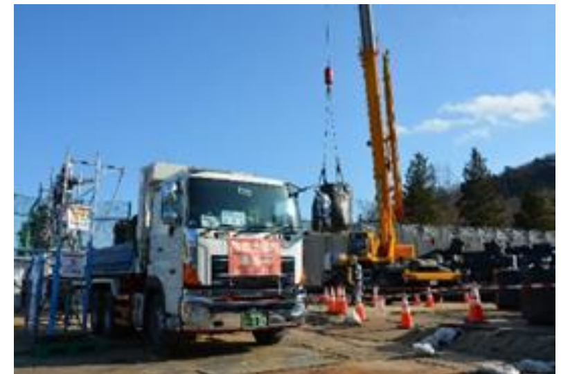
除去土壌の搬出（仮置き場）
