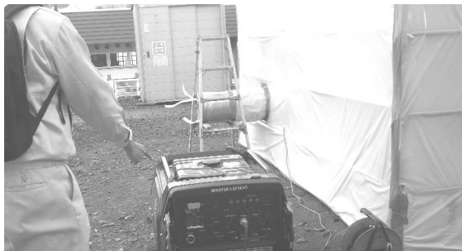
特定粉じん排出作業の養生検査
