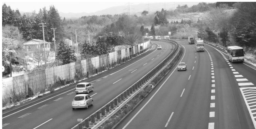
東北自動車道（松川パーキングエリア付近）
