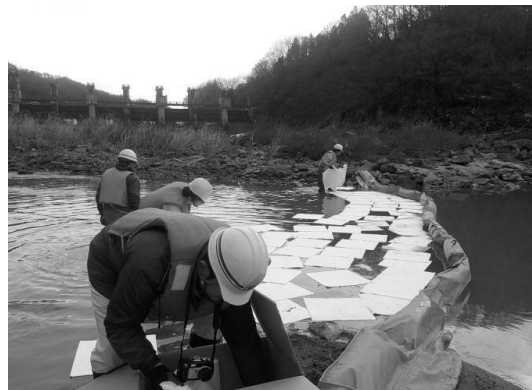
水質事故対応（オイルフェンス設置）
