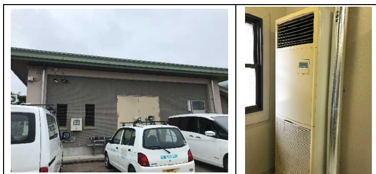
中央部受水池電気設備設置室及び設置室内空調設備
