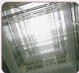
空気の通り道をつくるエコシャフトの中
