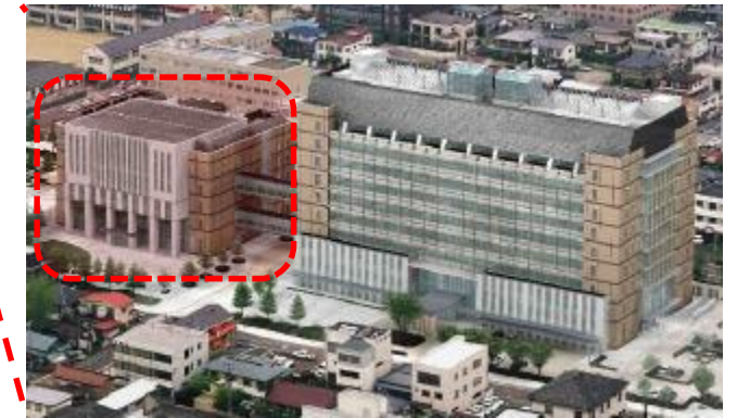
※当初の市役所本庁舎 建設イメージ(※写真左が西棟) 【東棟:平成22年度竣工】 【西棟:平成25年度竣工(予定)】
