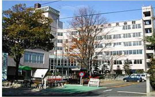
市民会館/敬老センター (築47年)
