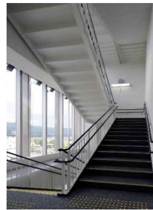
ユニバーサルデザインの階段の例 (福島市役所東棟)
