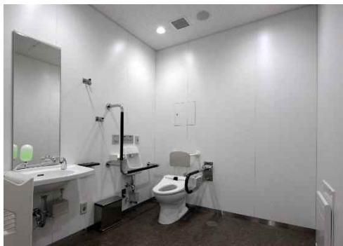
多目的トイレの例（福島市役所東棟）
