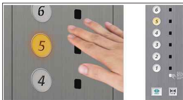
エレベーターの非接触型スイッチ
