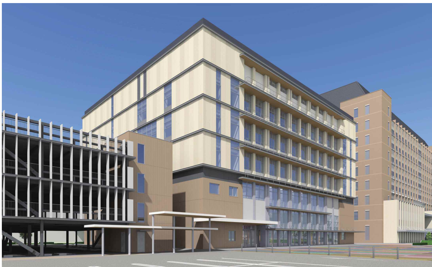
南西部より（仮称）市民センターを見る
