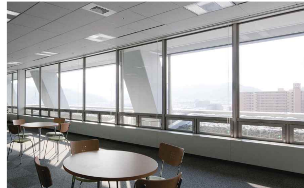
開閉が容易な窓の例 (市役所本庁舎)
