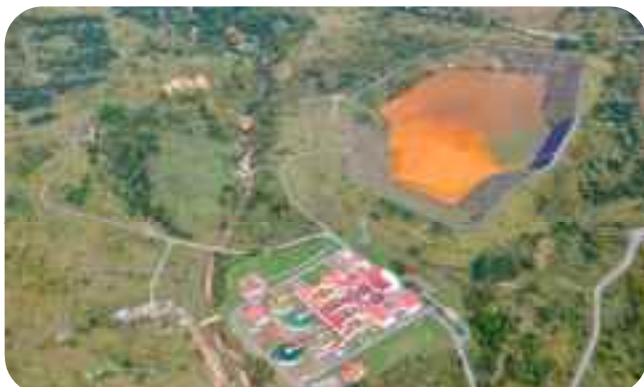
水質浄化施設
