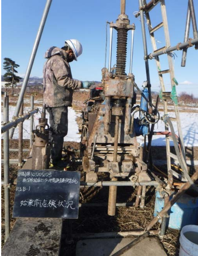
始 業 前 点 検 状 況
