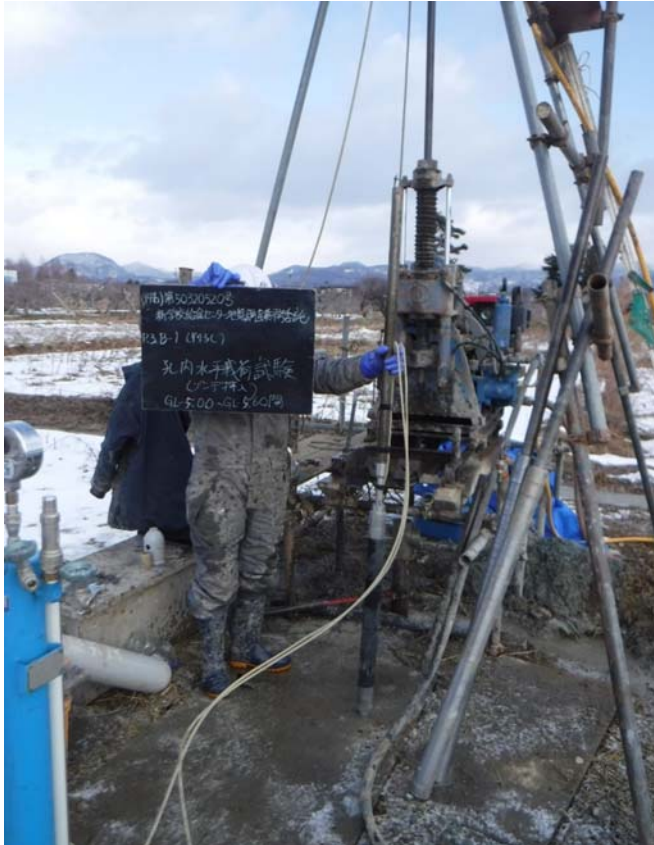
別孔 孔内水平載荷試験ゾンデ挿入状況 GL-5.0~5.6m
