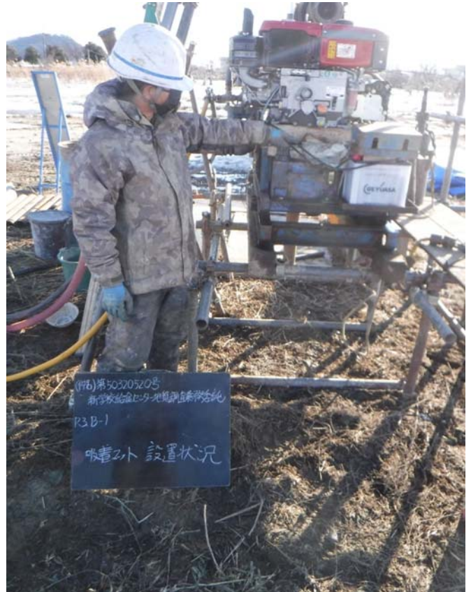
油 吸 着 マ ッ ト 設 置 状 況
