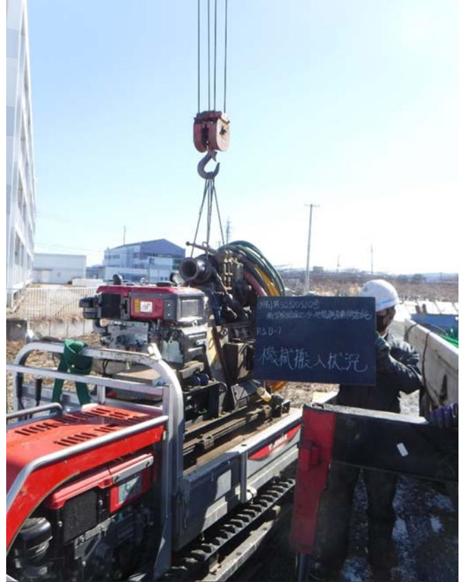
機 械 搬 入 状 況
