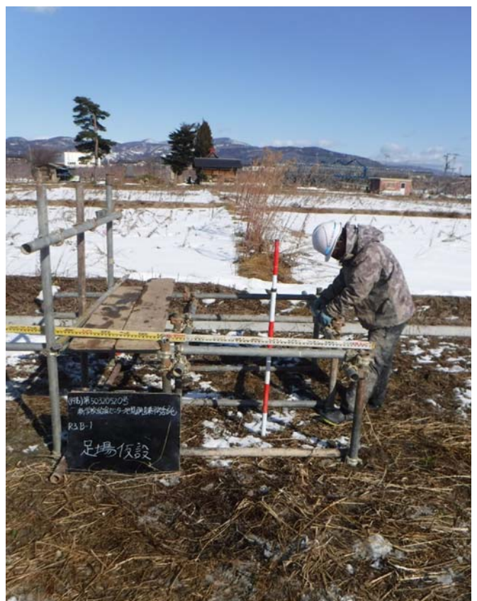
足 場 仮 設 状 況
