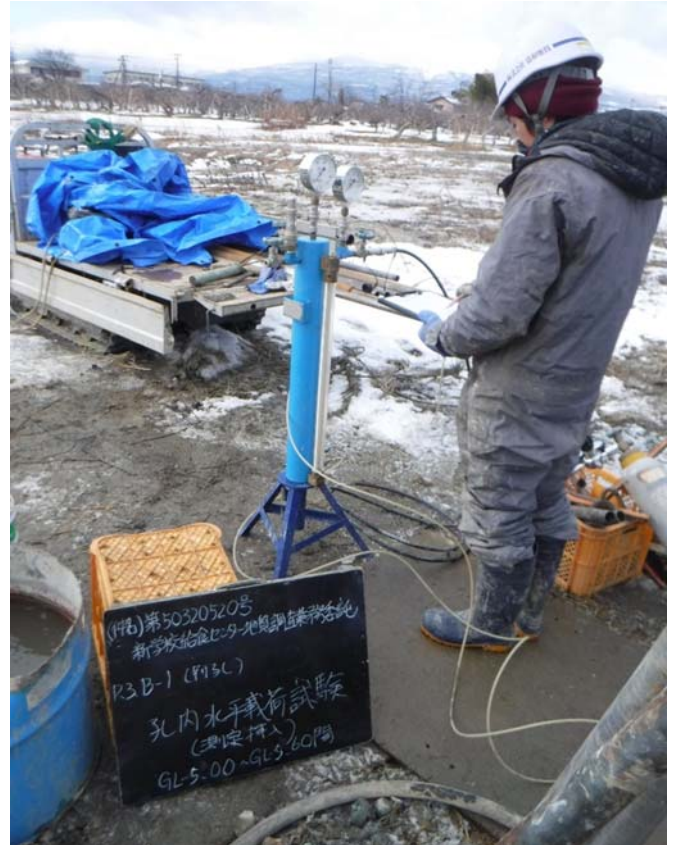
別孔 孔内水平載荷試験測定状況 GL-5.0~5.6m
