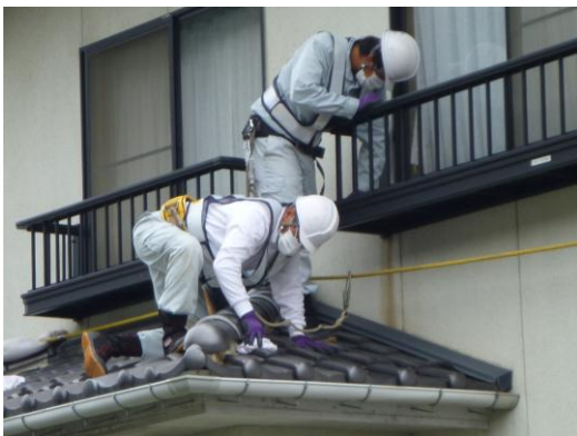
住宅の除染（屋根・雨どい）：拭き取りなどによる堆積物の除去作業
