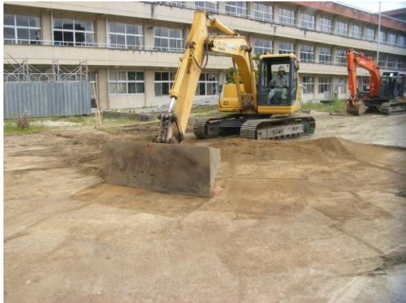
校庭の表土除去作業 (市内の小中学校、幼稚園95施設で実施)
