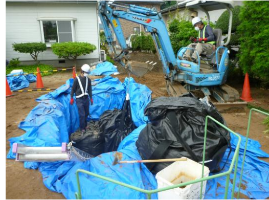
住宅の除染（現場保管）：地下埋設方式
