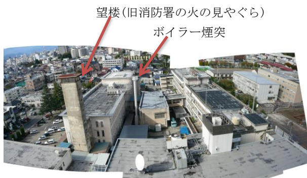
解体直前の旧庁舎
