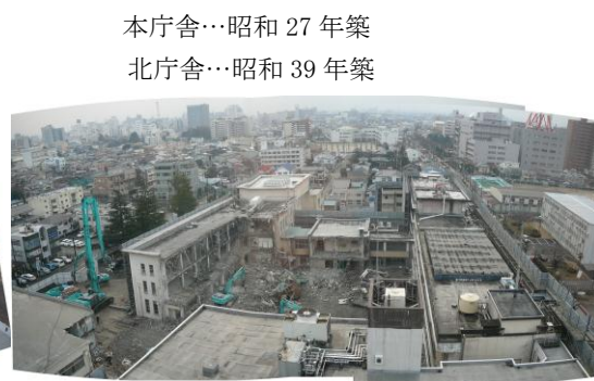
解体中(H23.3.8)の旧庁舎
