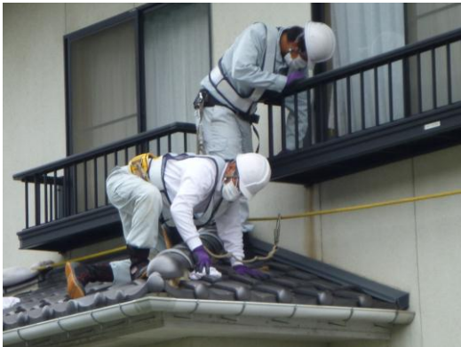
住宅の除染（屋根・雨どい）：拭き取りなどによる堆積物の除去作業
