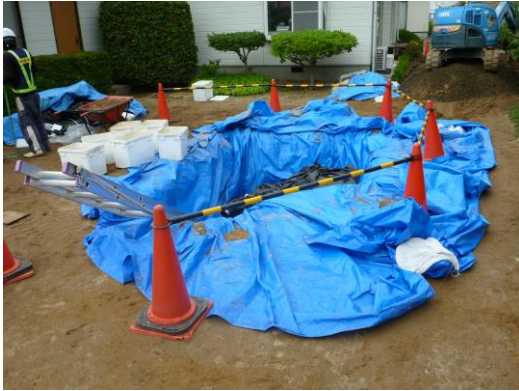
住宅の除染（現場保管）：地下埋設方式
