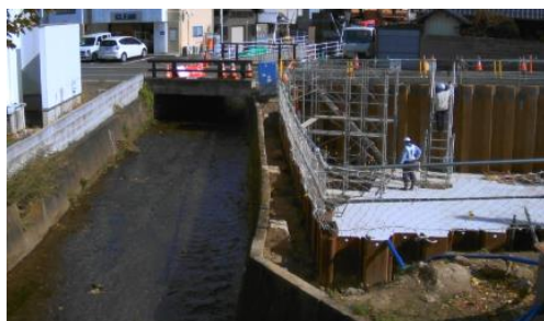
▲ 祇川に整備中の雨水貯留施設
