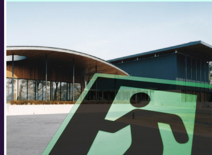
蓄光材(ルナウェア)による避難誘導
