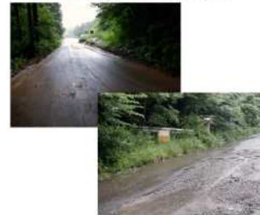
豪雨による道路への泥水流出の状況
