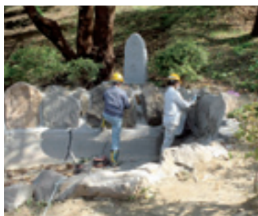
▲石の表面や表土に付着した放射性物質を削り取ります
