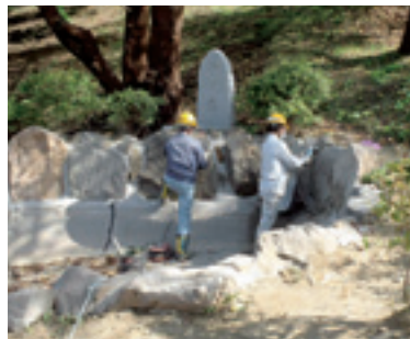
▲石の表面や表土に付着した放射性物質を削り取ります
