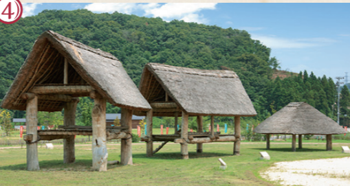
④ 掘立柱建物
