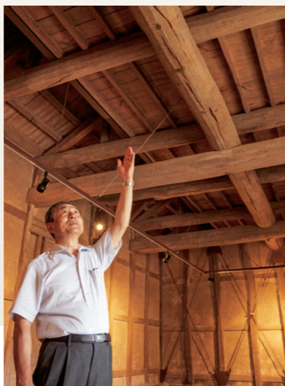
前鉋で仕上げた全長14メートルの中梁
