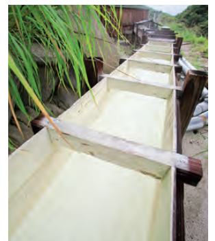
▲桶のふたを開閉したり、分湯箱で湯量を増やしたり絞ったりして温度を調節
