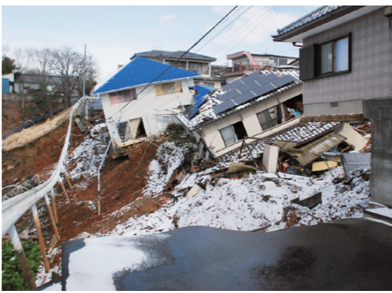
▲のり面が崩れ、甚大な被害を受けたあさひ台団地（伏拝）
